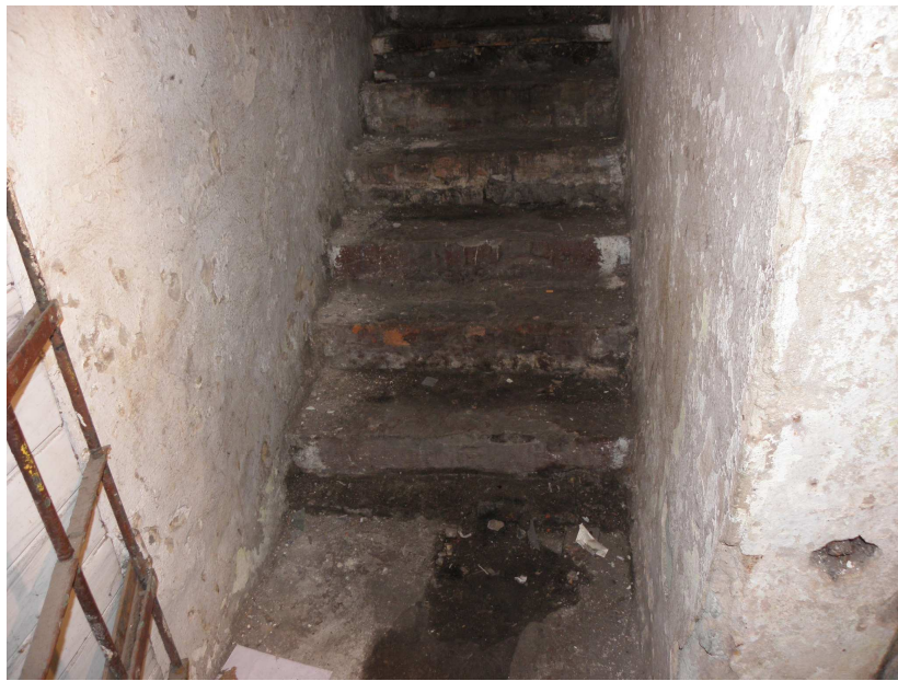
Fot – zejście do piwnic
