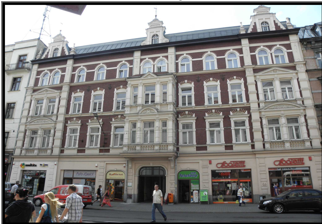
Fot. 1 – elewacja frontowa
