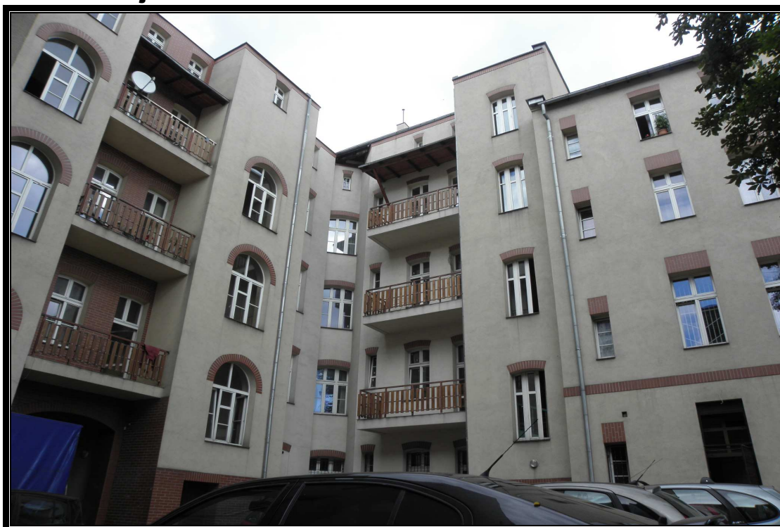
Fot. 2 – elewacja od strony dworca pkp
