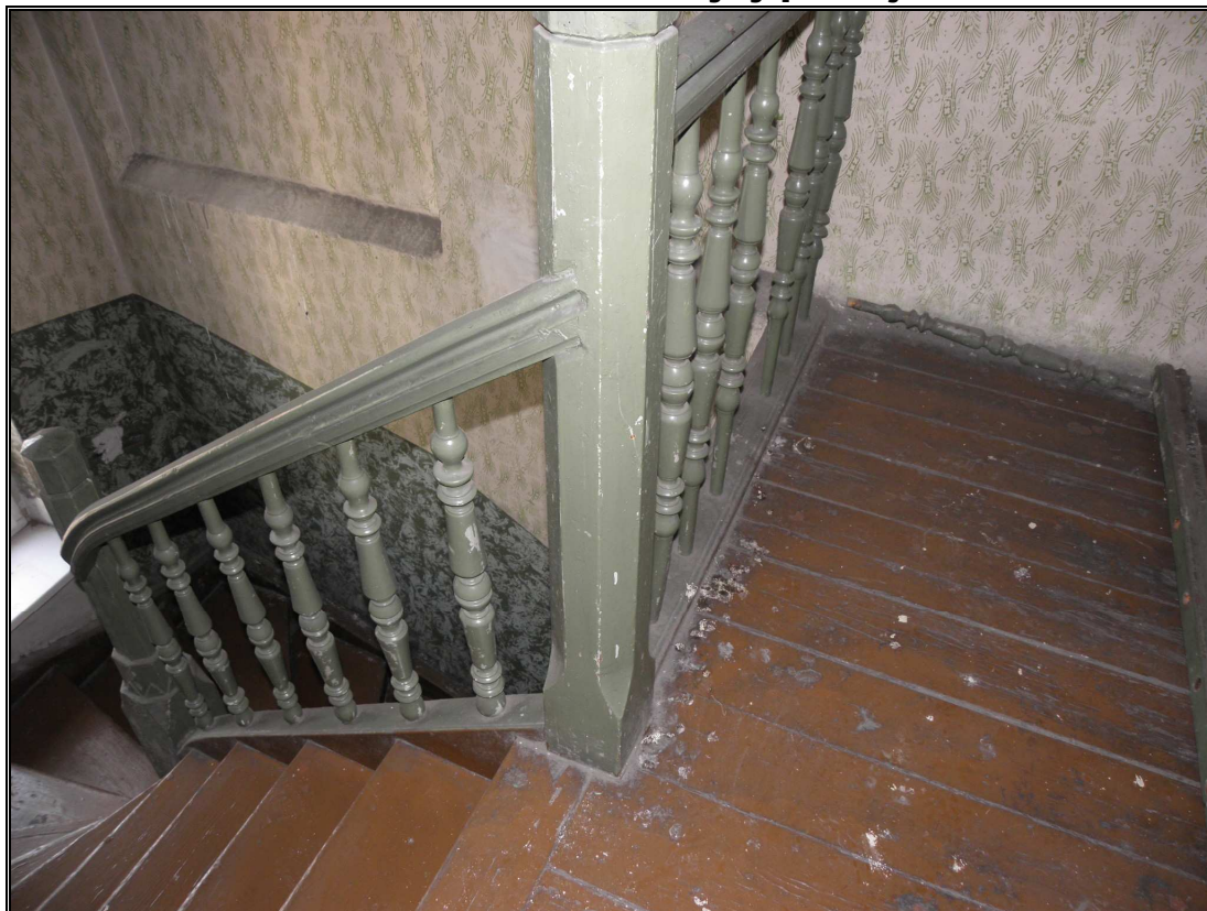
Klatka schodowe oficyny prawej
